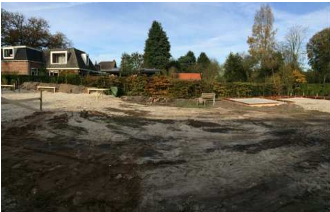
...onderkant bouwplanken (links op de foto) is het peil van onze woning; zie het verschil in niveau met de rest van de tuin (verschil bedraagt 70 cm)
