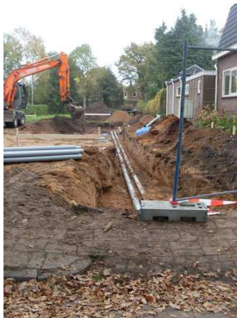
...graven van rioleringsleuf in onze oprit....(30 oktober 2014) Installatiewerk c.a. door Installatiebedrijf Hoekstra BV in Heerenveen
