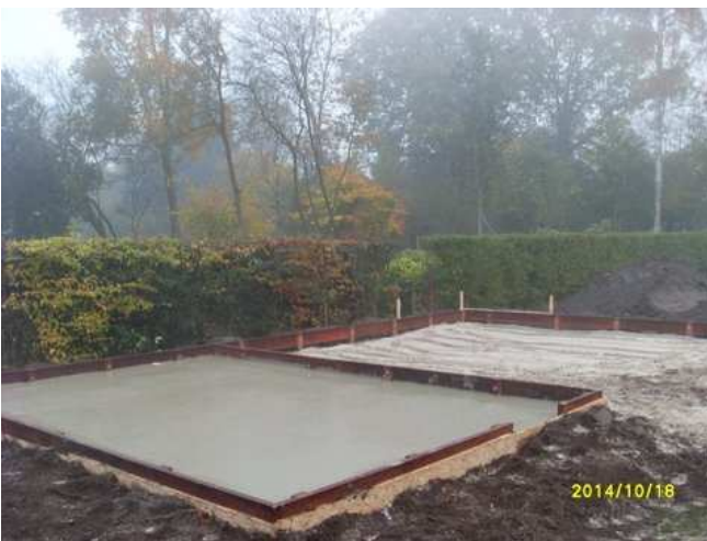
...betonvloer van de carport gestort! (5 november 2014)
