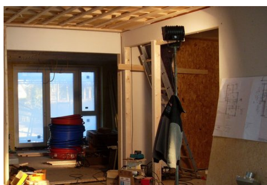
...honderden meters leiding liggen te wachten op installatie....
