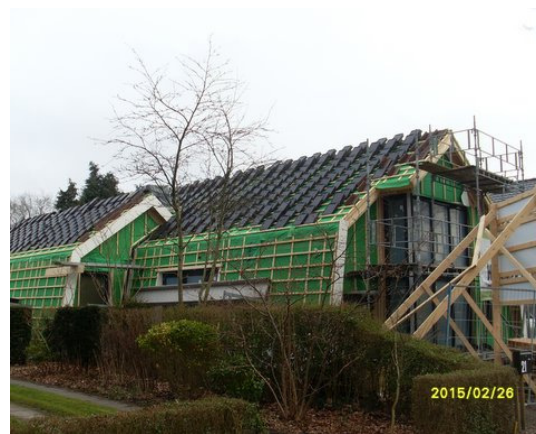
De kraan heeft de dakpannen (in totaal 3000 stuks) in sets op het dak geplaatst.
