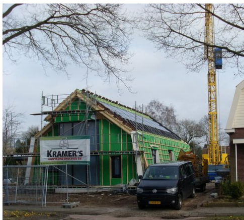
De kraan heeft de dakpannen (in totaal 3000 stuks) in sets op het dak geplaatst.
