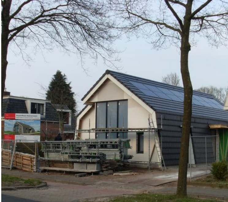
We vinden ons huis iedere week mooier worden© . Dakpannen, boeidelen, zonnepanelen en entree zijn klaar! De voorgevel is bekleed met permoxx; hierop worden nog steenstrips bevestigd.
