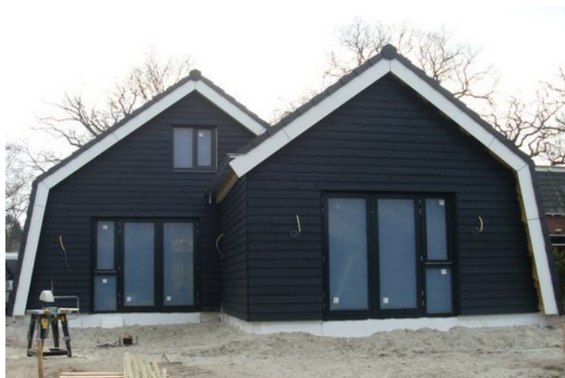
De kraan heeft de dakpannen (in totaal 3000 stuks) in sets op het dak geplaatst.
